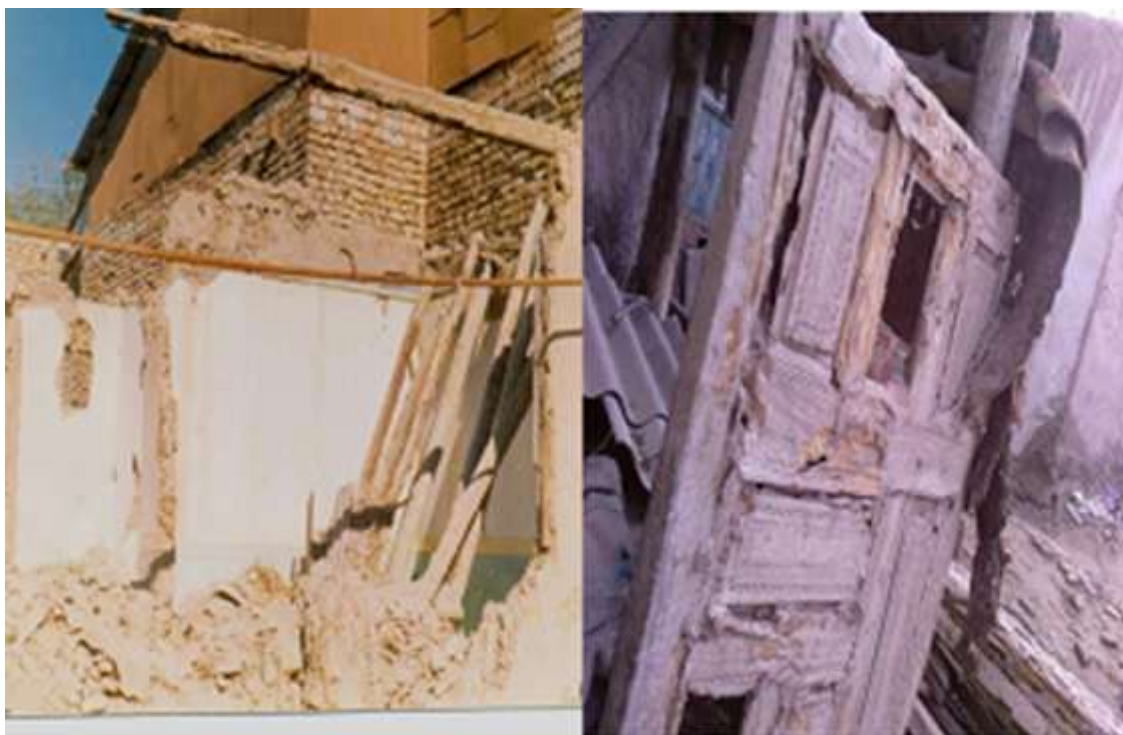
3.1-сурет- термиттерден бұзылуға бейім тұрғын үйге сынақ жүргізілу барысы
