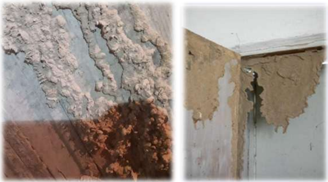
2.3 -сурет- термиттерден зақымданған тұрғын үйлер
