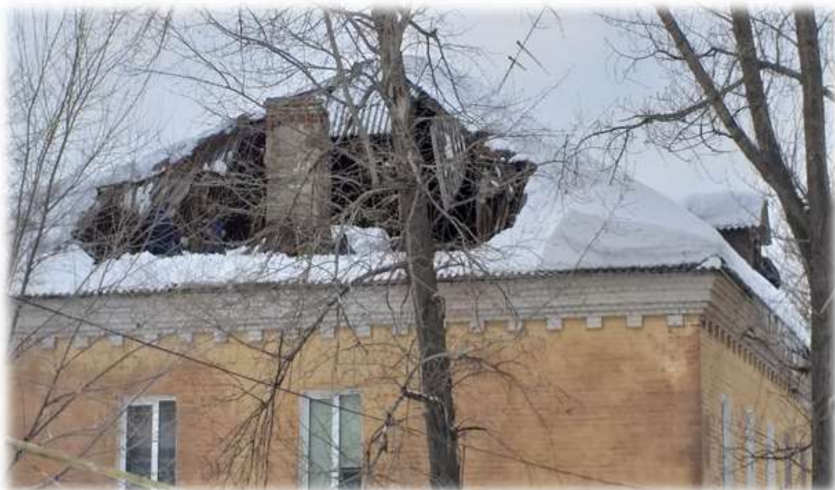
3.5-сурет-Термиттерден зардап шеккен ғимарат
