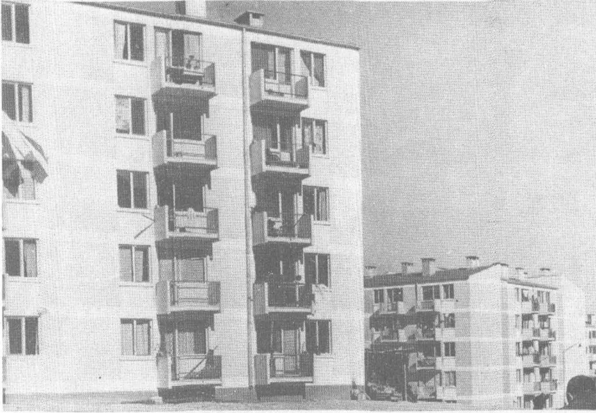
“SOSYAL KONUT” SORUNU: İkinci Dünya Savaşı’ndan sonra yaygınlık kazanan “sosyal konut” örnekleri bizde belediyeler, Emlâk ve Kredi Bankası, Sosyal Sigortalar Kurumu vb. tarafından gerçekleştirilmeye başlanmıştır. Ancak, İstanbul Osmaniye’de Belediye tarafından yaptırılan “Sosyal Meskenler”de olduğu gibi, yapım sırasında yeterli denetim yapılmaması nedeniyle, yerleşimden bir süre sonra kimi konutlar oturulamaz duruma gelmiş ve boşaltılmıştır.
