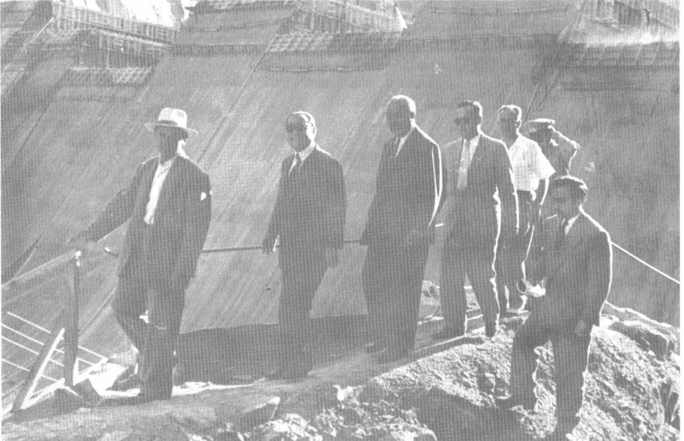
BÖLGESEL ÖRGÜTLENMELER: 1950'li yılların sonlarına doğru Karayolları Genel Müdürlüğü, Devlet Su İşleri Genel Müdürlüğü, Orman Genel Müdürlüğü, Toprak Su Genel Müdürlüğü, Yol Su Elektrik İşleri Genel Müdürlüğü, Toprak İskân Genel Müdürlüğü, Çalışma Bakanlığı gibi kuruluşlar tarza örgütlenmesinde mülki idare sisteminin dışına çıkarak kendi bölgesel örgütlerini kurdular. Dönemin başbakanı Adnan Menderes, Sürüyer Barajı inşaatında incelemeler yaparken.
