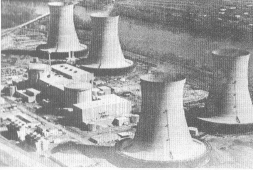
RADYOAKTİF SIZINTI: ABD'de Harrisburg kentinde Edison Elektrik Şirketi'ne ait atom reaktörlerinin birinde 1979'da radyoaktif sızıntı oldu. Bir soğutucu pompasının bozulması üzerine radyoaktif enerji atmosfere karışınca, reaktör kapatıldı. Sızıntının 2 saatten fazla sürdüğü tahmin ediliyor.
