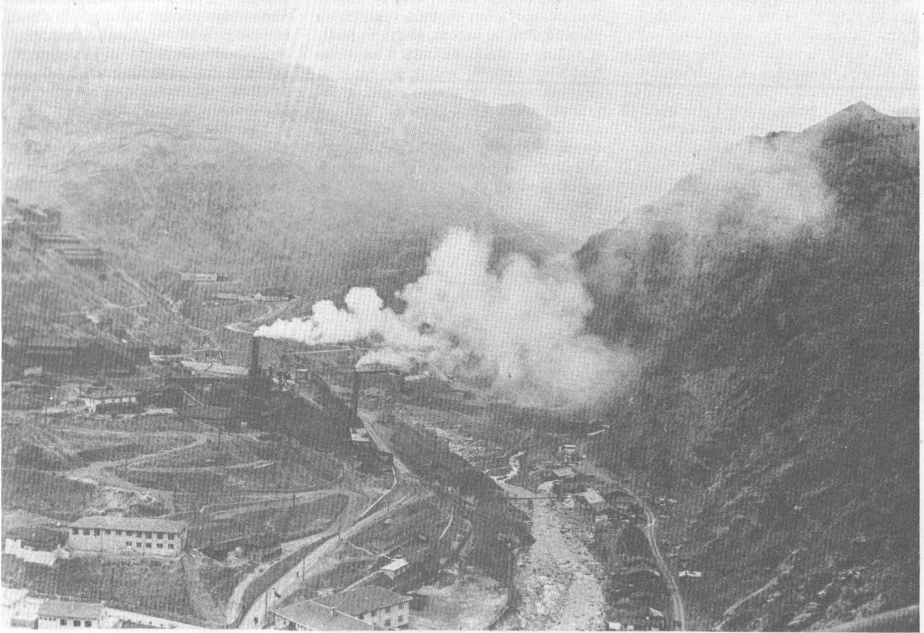
DOĞU'DA HAVA KİRLENMESİ: Doğu Anadolu da yoğun bir biçimde kirlenmeye başladı. Murgul Bakır Fabrikası'ndan çevreye yayılan gazlar fabrikanın oldukça geniş bir çevresinde etkili oluyor. İzabehane bacalarından günde ortalama 80-100 ton SO_2 gazı çıkıyor. Bu gazlar 10 bin hektarlık araziye ciddi bir biçimde kirletiyor. Murgul'da son 10 yıl içinde 150 bin m^2 den fazla orman örtüsünün ortadan kalktığı görülüyor.
