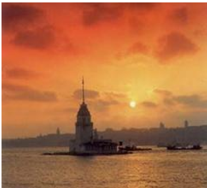
Башня Кыз Кулеси
