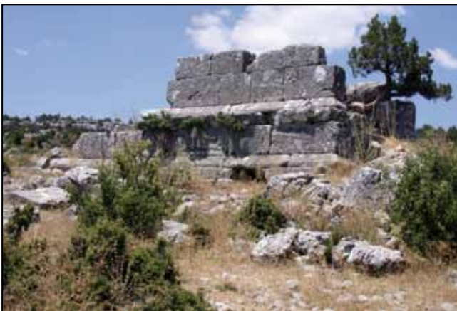
3- Heronun Güneydoğudan Görünümü.
