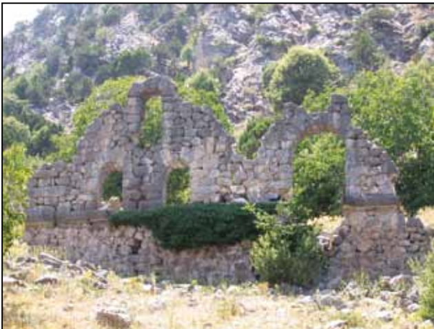
3- Podyumlu Yapının Doğudan Görünümü.
