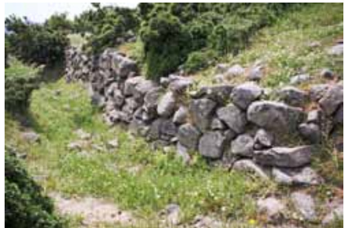
Yerleşimin kuzey bölümündeki savunma duvarı kalıntıları
