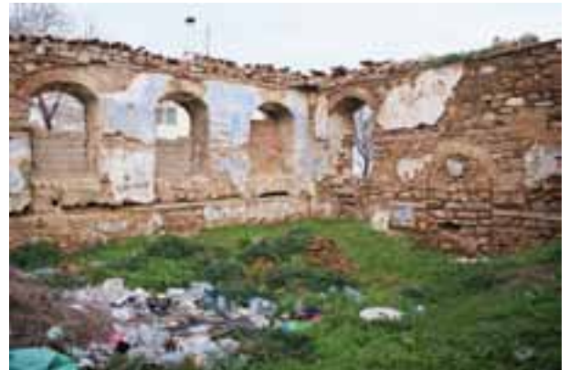
Hamamın sıcaklık bölümü
