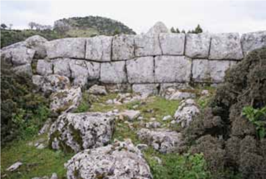
Yerleşimin kuzeybatı bölümünde bulunan sur duvarı kalıntıları
