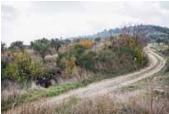
Bataryanın bu günkü durumu
