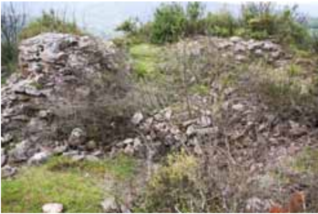
Yerleşim üzerindeki kireç harçlı duvar kalıntısı
