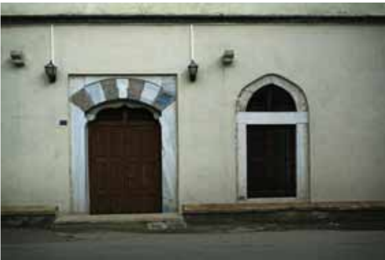
Hamamın kapı ve pencereleri
