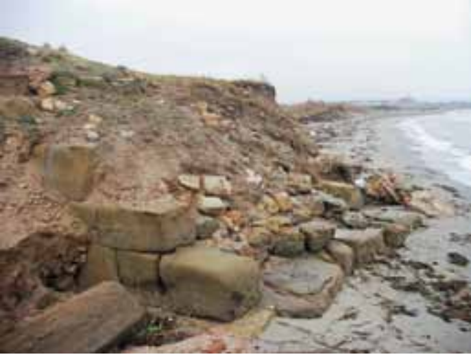
Sur duvar kalıntısı
