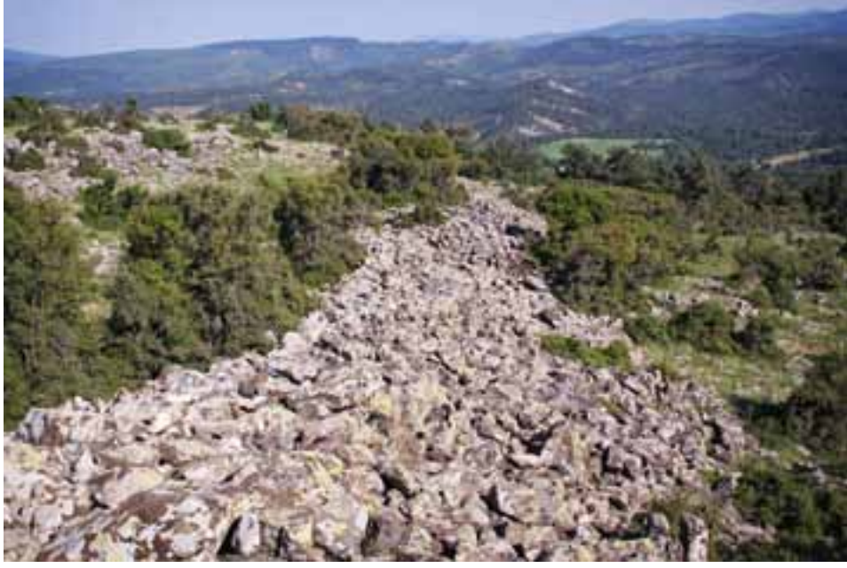
Sur duvarlarının görünümü
