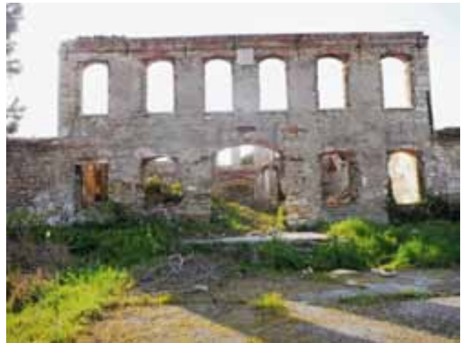
Yapının arka cephesi
