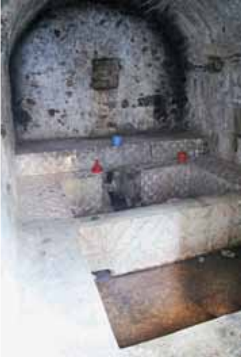
Kaplıca yapısının içinde bulunan tekneler,
