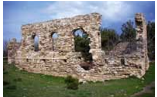
Kale içinde bulunan camiye ait kalıntı
