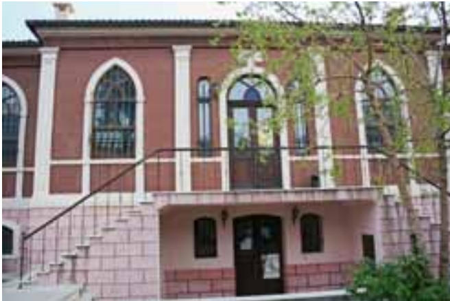
Yapının önden görünümü
