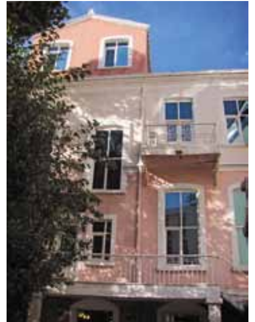
Yapının arka cephesi
