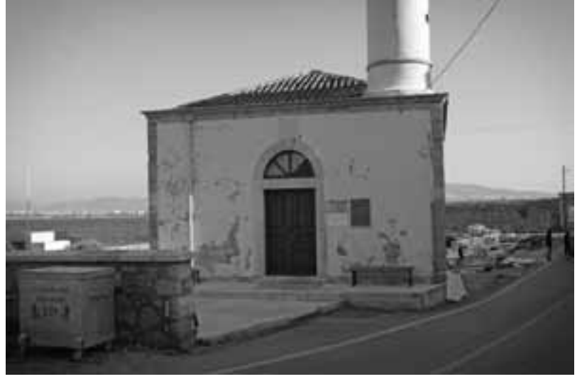
Tabib Hasan Paşa Camii'nin genel görünümü
