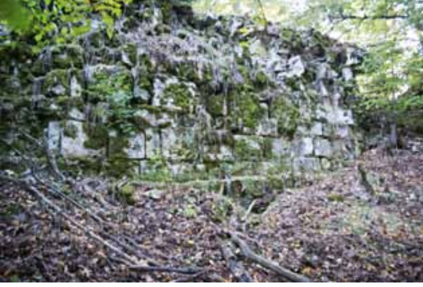
Kalenin Kuzey duvar kalıntıları
