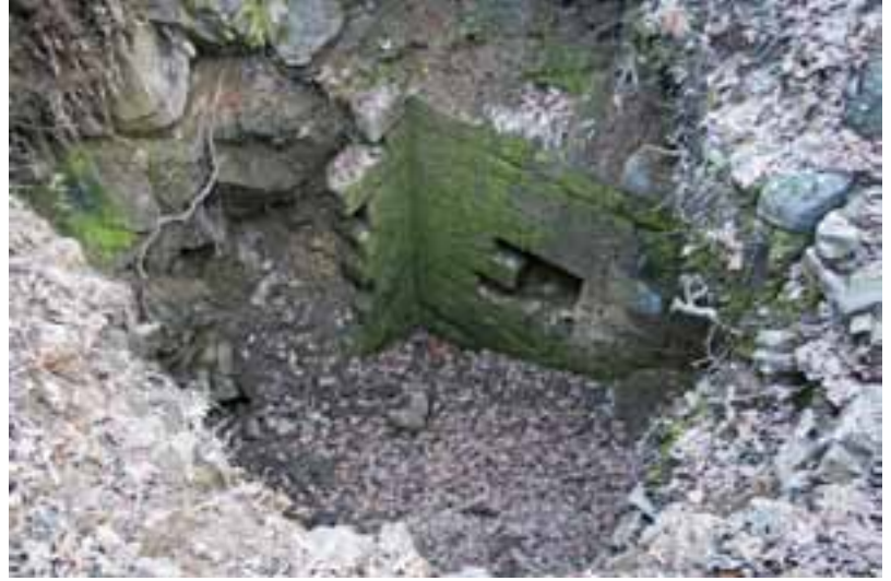
Dedetepe üzerindeki yapı kalıntısı (sarnıç)
