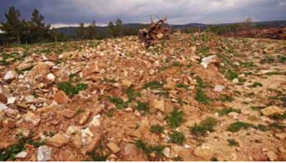
Tepenin üst kısmında bulunan tahrip olmuş yapı kalıntıları
