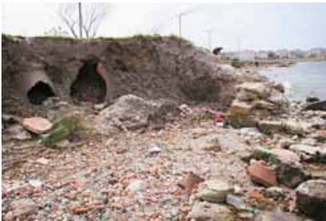
Liman yapılarına ait temel kalıntıları
