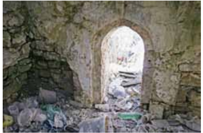
Hamamın sıcaklık bölümü
