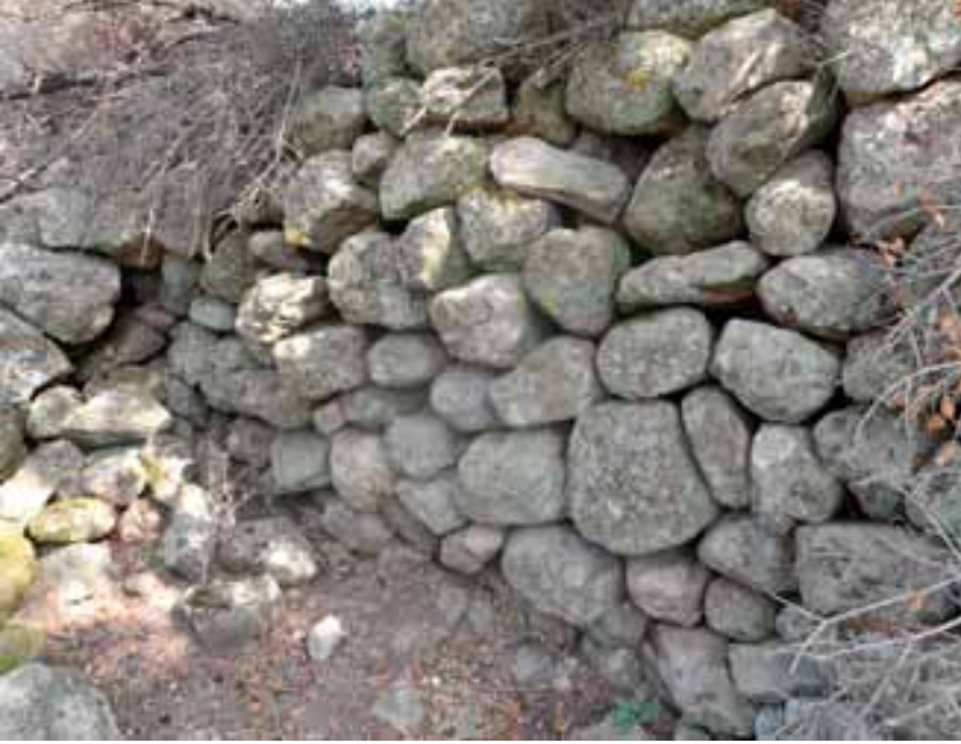
Atölye atıklarından yapılmış bahçe duvarı
