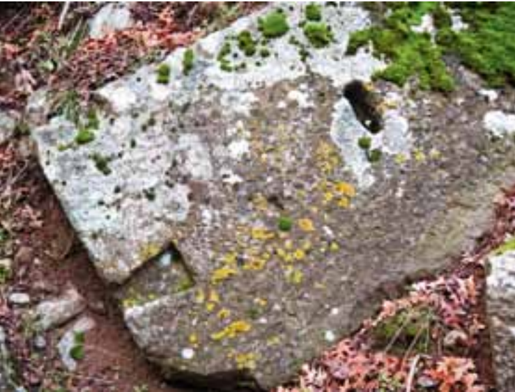
Su kemerinin yapı taşlarından detay
