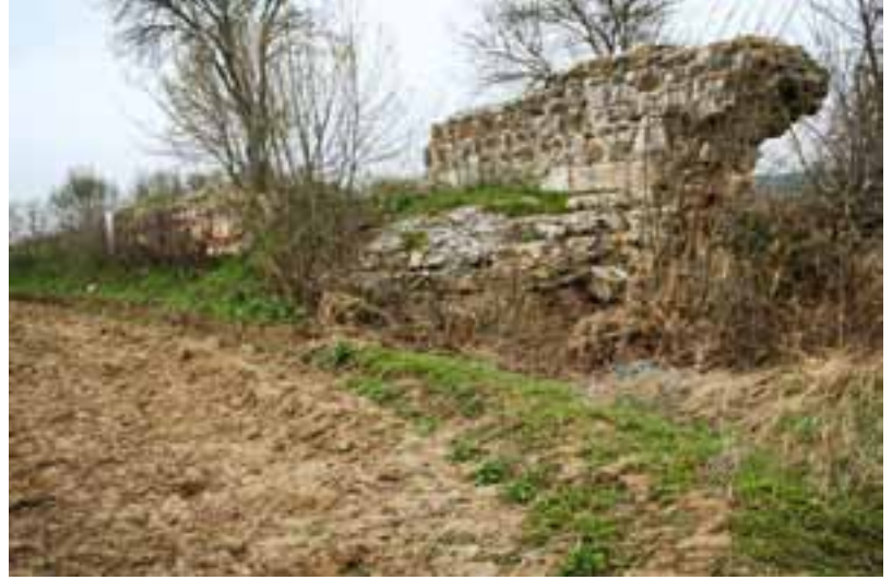
Akköprü köprüsünün genel görünümü
