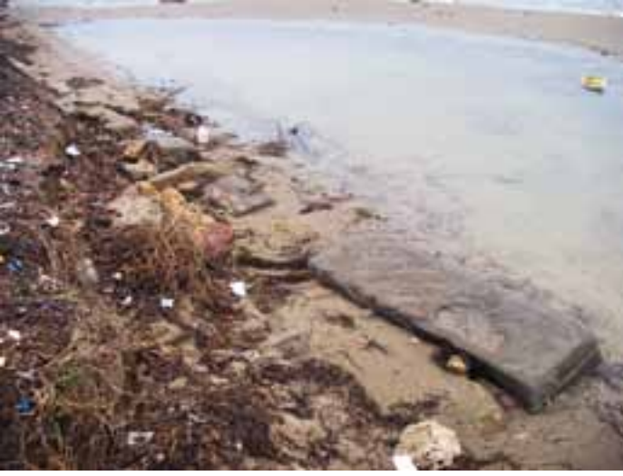
Liman Yapıları kalıntıları
