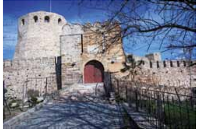
İç kalenin sur duvarı ve burçları
