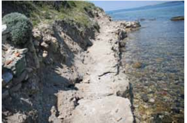
: Liman yapılarının duvarları
