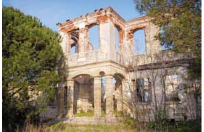
Yapının ön cephesi
