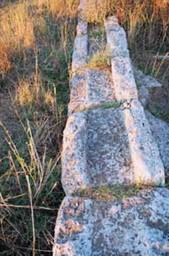
Köprü kenarındaki mermer parapet (korkuluk) yuvaları
