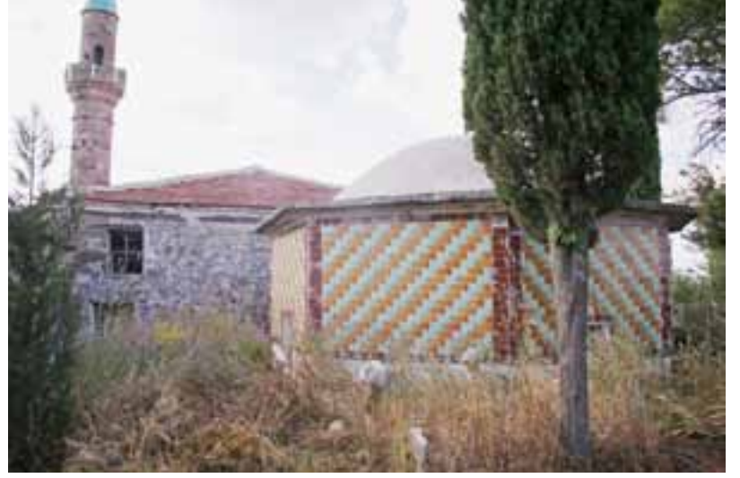
Yahşibey türbesi ve camisinin genel görünümü
