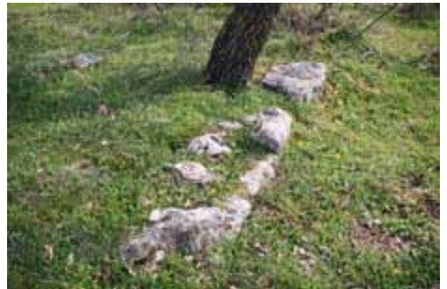
Yerleşmenin üzerinde bulunan temel izleri
