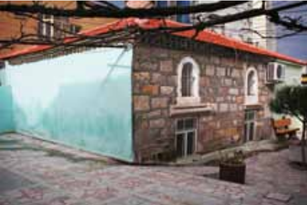
Caminin güney batı cephesinden görünüm.
