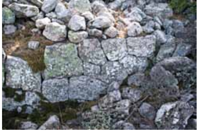
Yukarı Kentte bulunan poligonal teknikte yapılmış sur duvarı kalıntısı
