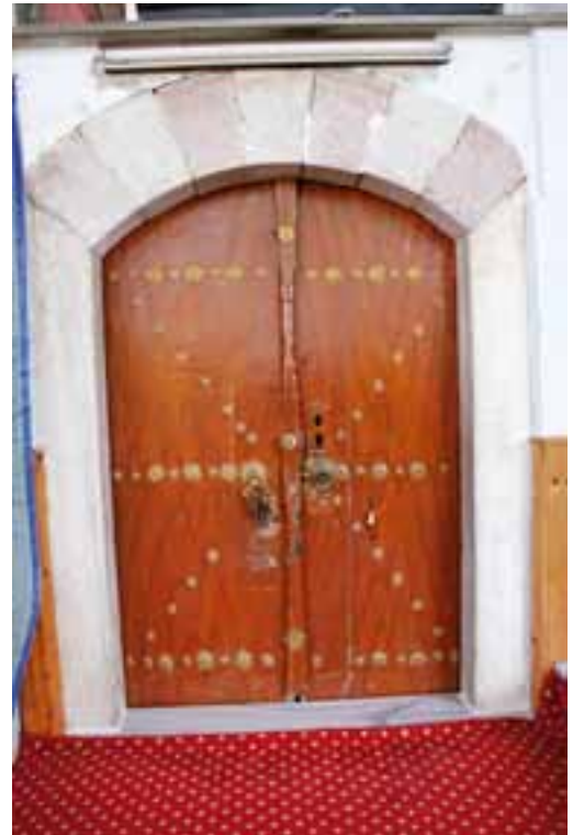
Cami'nin giriş kapısı,
