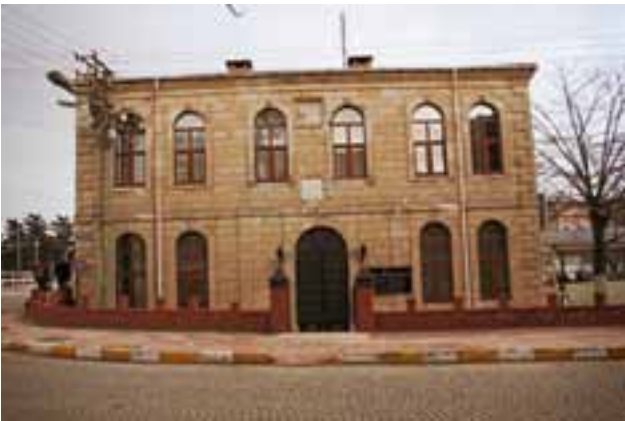
Yapının ön cephesi
