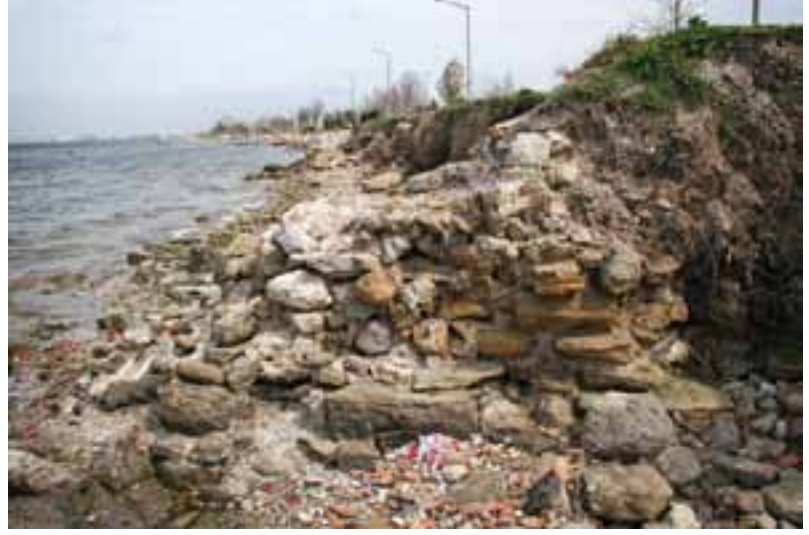
Liman yapılarına ait temel kalıntıları
