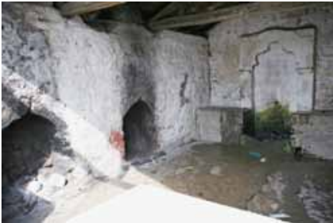
Çamaşırhanenin iç görünümü ve çeşme
