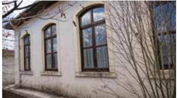
Okulun arka cephesi
