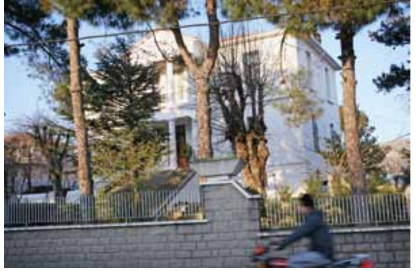
Metropolit binasının genel görünümü
