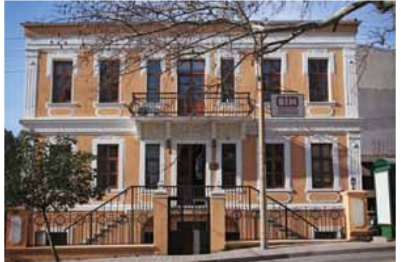
Yapının ön cephesi
