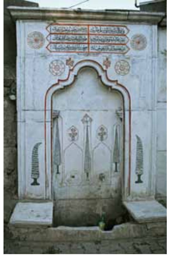
Çeşmenin ön cephe görünümü
