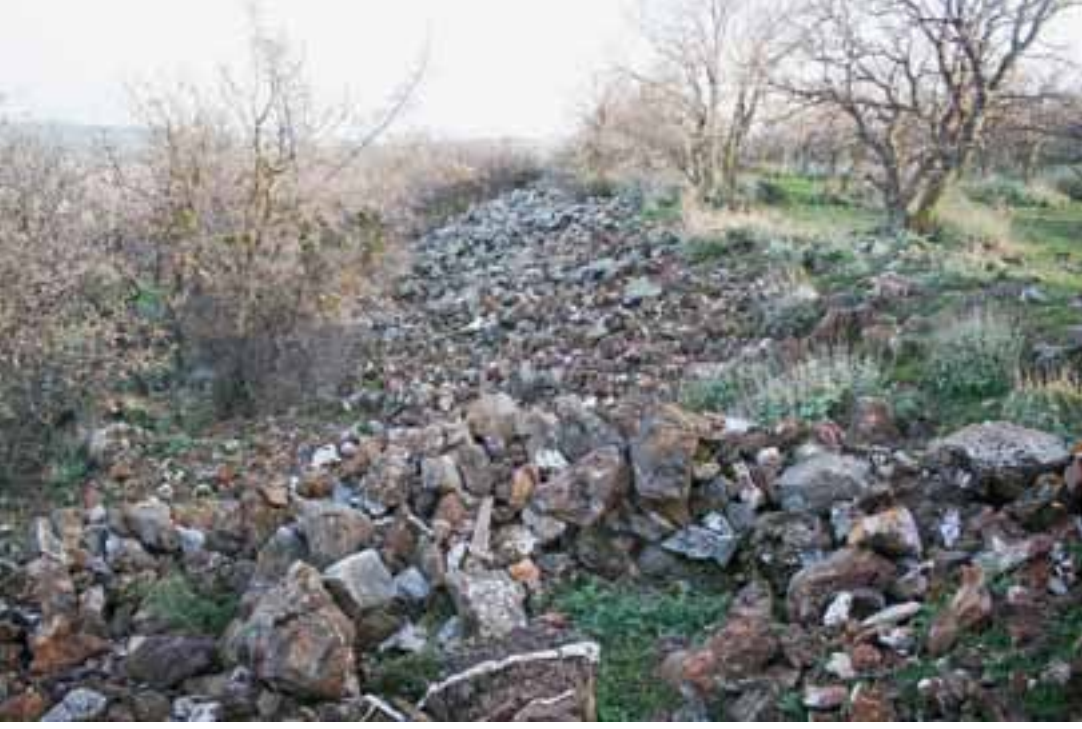
Sur duvarlarının bu günkü durumu
