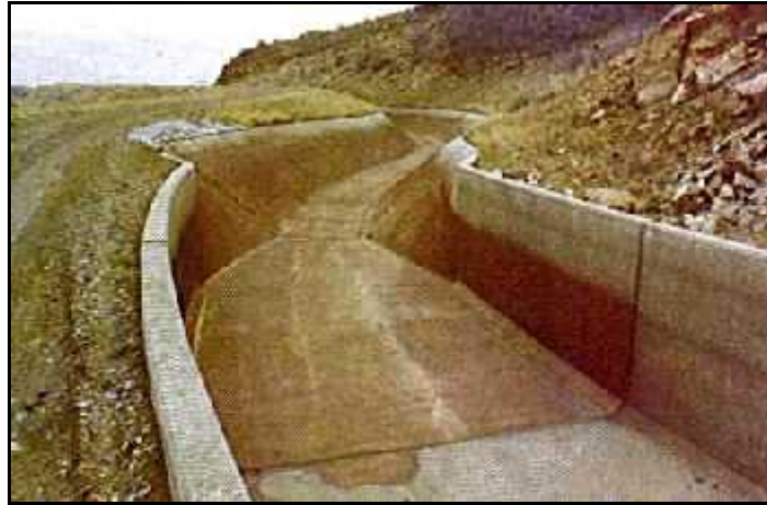
Şekil 7. 26.A.B.D.'lerinde Tutunmayı Önleyici Boya Uygulanmış Beton Kaplamalı Sulama Kanalı (208)
