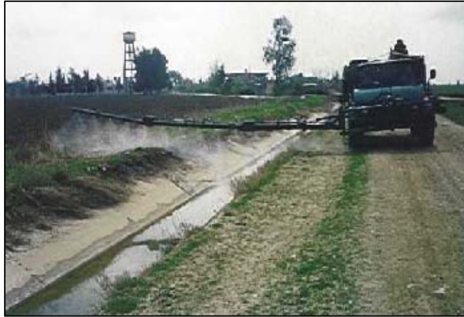
Şekil 7.8.Sulama Kanalı Banketlerinde Banket Yabancı Otlarına Püskürtme Yöntemi ile İlaçlama Yapılması
