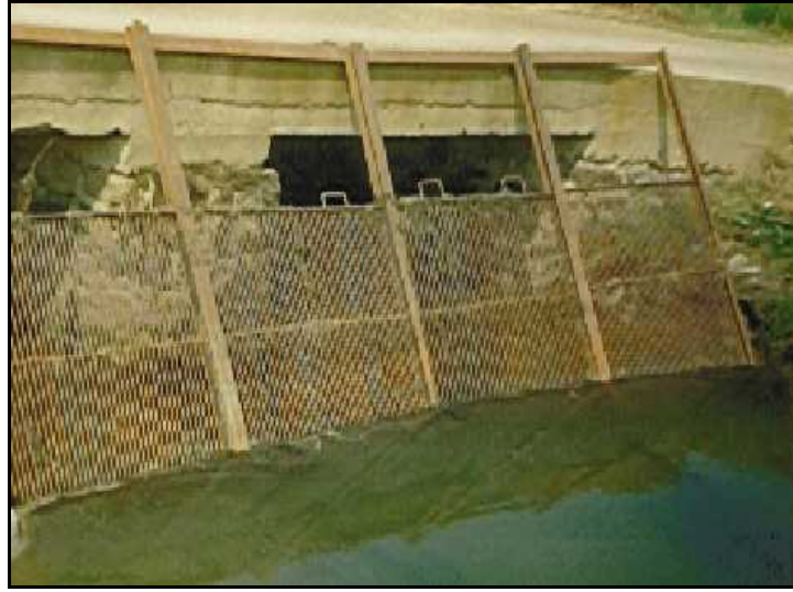
Şekil 9.23. Fakara Deresi Boşaltma Kanalına Yerleştirilen Izgara
