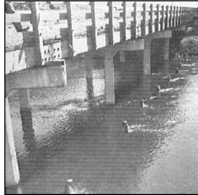
Şekil 7.18. Sulama Kanallarında Torba Yöntemi ile Göztaşı Uygulaması (208)
