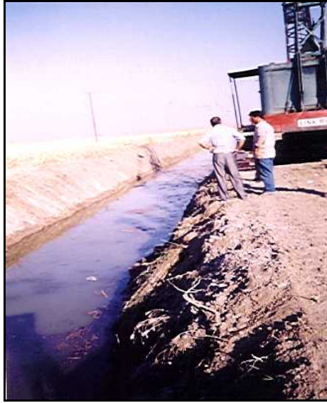
Şekil 6.9. Tortu Temizliği Yapılmış Boşaltma Kanalı
