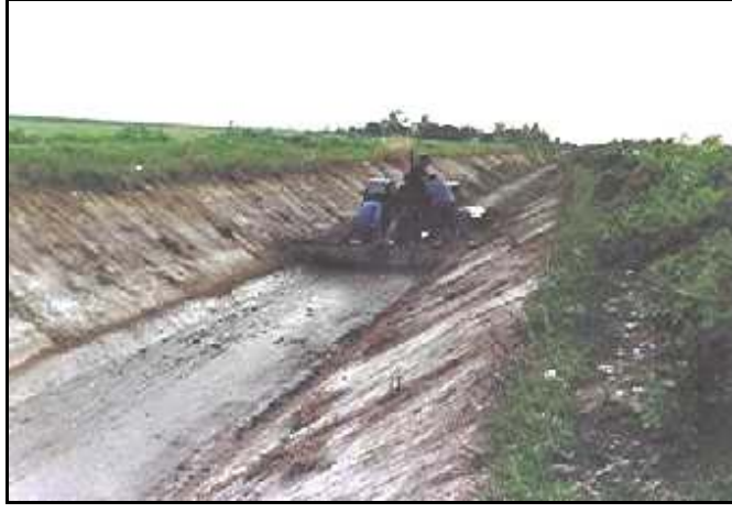
Şekil 6.5. Beton Kaplamalı Sulama Kanalında Traktör ile Tortu Temizliği
