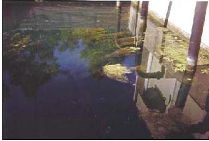
Şekil 2.15.Pompa İstasyonu Girişinde Yabancı Ot Sorunları
