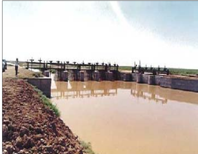
Şekil 6.22.Harran Sulaması Ana Boşaltma Kanalı ve Küplüce Regülatörü (117)
