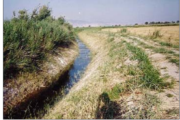
Şekil 5.18.Biçme Kepçesi Takılı Uzayıp Kısalabilen Kolları Bulunan (teloskopik boom) Makine ile Biçilmiş Boşaltma Kanalı
