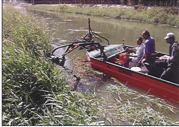
Şekil 5.5. Eskişehir Sulaması Ana Sulama Kanalı Şevlerindeki Su Üstü Yabancı Otlarının Biçme Kayığı ile Biçilmesi
