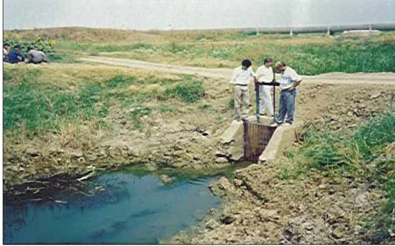
Şekil 9.20.K1-010 Tersiyer Drenaj Kanalı Mansabına Yerleştirilen Izgara
