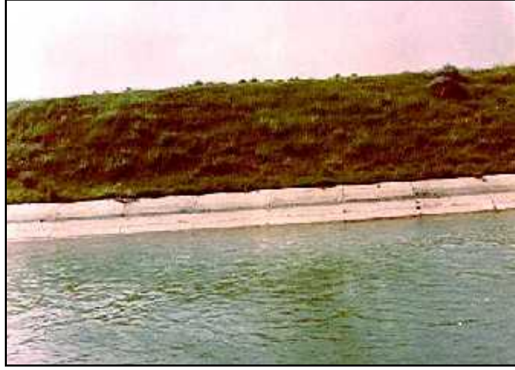
Şekil 6.30.Sulama Kanalı Şevlerinde Bitkisel Kaplama Çalışması
