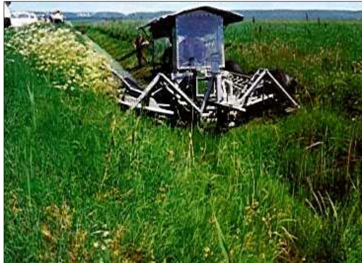
Şekil 5.24. Örümcek (Makine Tekerlekleri Kıyıda Olmak Üzere Kanal İçinde Çalışır. Makineye, biçme kolu, kazma kepçesi, tırmık, biçme kepçesi takılabilir)
