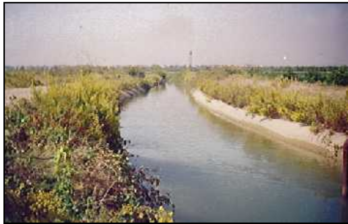
Şekil 2.13.Sulama Kanalı Şev ve Banketlerinde Odunsu Bitkiler ve Banket Yabancı Otları
