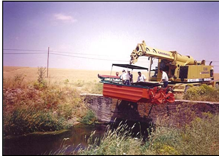
Şekil 5. 6. Eskişehir Sulaması Ana Sulama Kanalında, Biçme Kayığının Sanat Yapısının Diğer Tarafına Aktarılması
