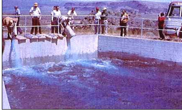
Şekil 7.17. Sulama Kanallarında Dökme Yöntemi ile Göztaşı Uygulamaları (208)
