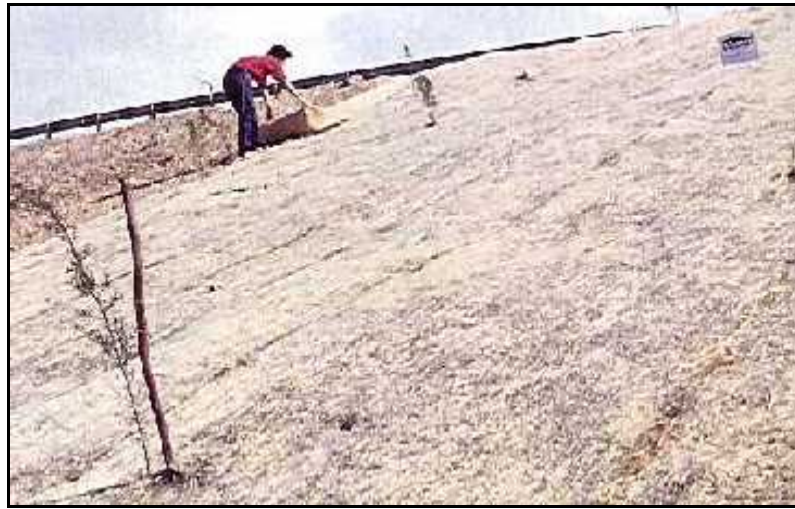
Şekil 6.32.Bitkisel Kaplamada"Yeşeren Halı" ya da "Tohum Şiltesi" Uygulaması
