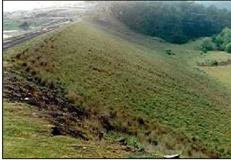
Şekil 6.31.Baraj Gövdesi Hava Tarafında Bitkisel Kaplama Uygulaması
