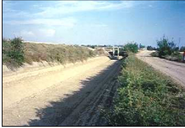
Şekil 2.14.Sulama Kanalı Şev ve Banketlerinde Odunsu Bitkiler ve Banket Yabancı Otları
