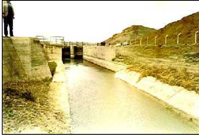
Şekil 6.17.Yaralı Sulaması Çökeltim Havuzu ve İsale Kanalının Mansaptan Görünüşü (107)
