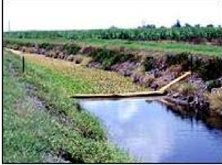
Şekil 5.27.Su Yabancı Otlarının Taşınmasını Engelleyen Bir Seren ( boom ) (181)
