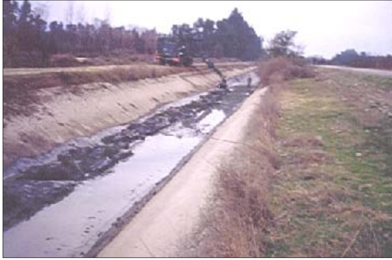
Şekil 6.6.Sulama Kanalında Teleskobik Kepçe Kollu (boom) İş Makinesiyle Tortu Temizliği
