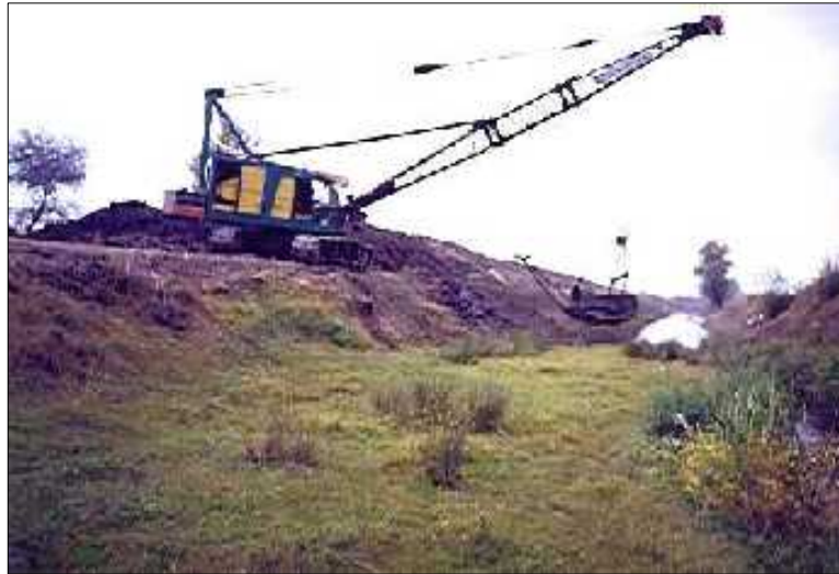
Şekil 6.3. Çekme Kepçeli Kazıcı İş Makinesi ile Boşaltma Kanalı Temizliği
