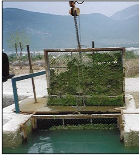
Şekil 2.16.İpliksi Alglerin Izgaralarda Neden Olduğu Tıkanmalar
