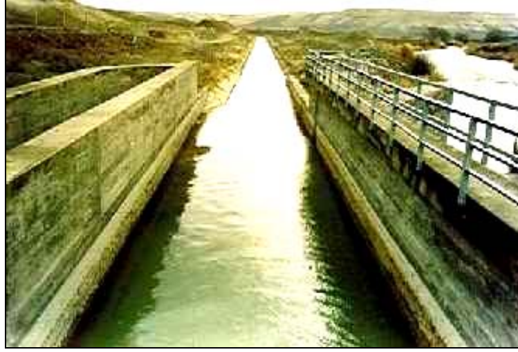
Şekil 6.16.Yaralı Sulaması Çökeltim Havuzu, Ana Kanal ve Çakıl Geçidi Çıkışının Membedan Görünüşü (107)
