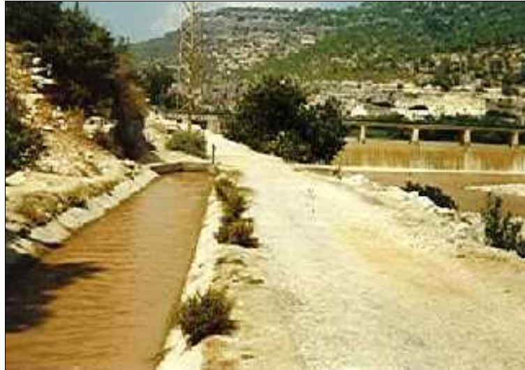
Şekil 6.15.Göksu Irmağından Su Alan Silifke Sulamasında Bağlama (Regülatör) ile Sağ Sahil Ana Sulama Kanalındaki Bulanık Suyun Görünüşü
