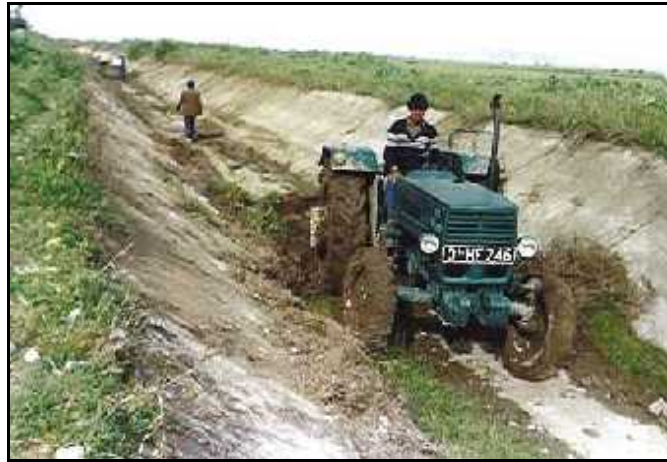
Şekil 6.4. Beton Kaplamalı Sulama Kanalında Traktör ile Tortu Temizliği
