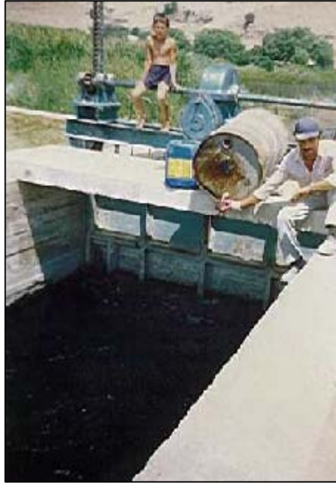
Şekil 7.20.Su altı Yabancı Otları ve İpliksi Algilere Endothall Uygulamalarında Seyreltilmiş İlacın Doğal Akış Yöntemi ile Kanal Suyuna Verilmesi
