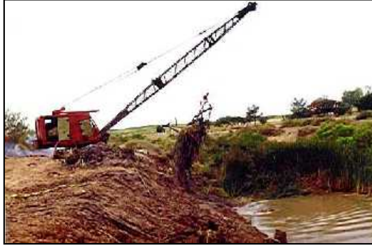
Şekil 6. 8.Çekme Kepçeli İş Makinesi ile Tortu ve Yabancı Ot Temizliği
