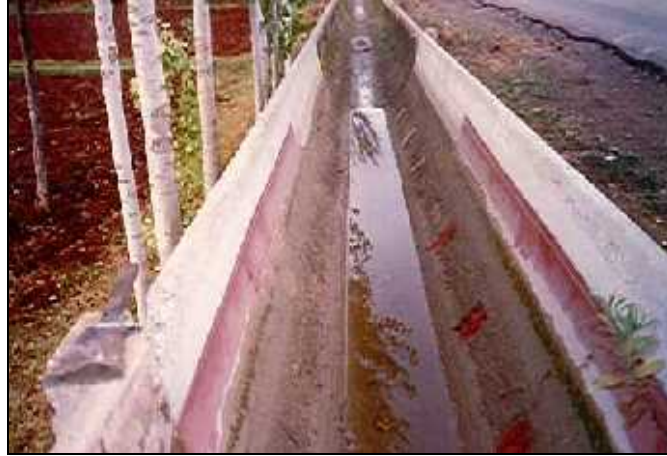
Şekil 7.25. Tutunmayı Önleyici Boyalarla Kanaletlerde Yapılan Denemeler
