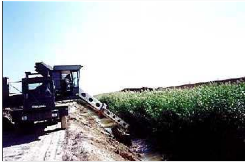
Şekil 6.7.Boşaltma Kanalında Teleskobik Kepçe Kollu (boom) İş Makinesiyle Tortu ve Yabancı Ot Temizliği
